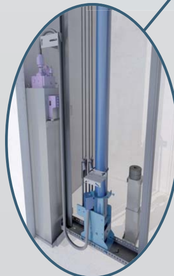
Detalle de instalación del tanque en el foso.
